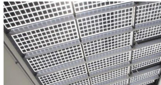
COPERTURA IN PANNELLI FOTOVOLTAICI TRASPARENTI
